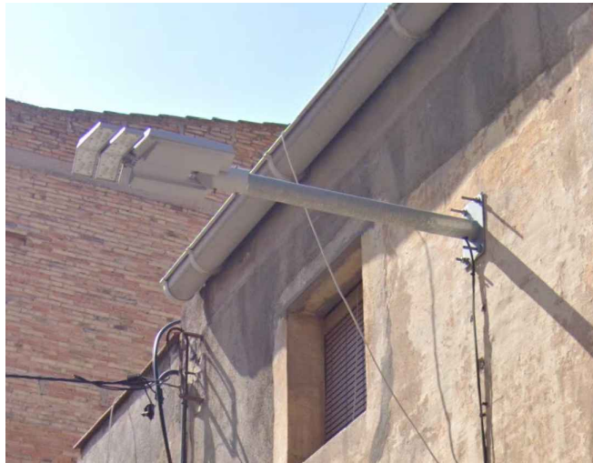
LLUMINÀRIA VMAX V2 (2 CHEVRON) AMB BRAÇ D'UN METRE AMB MONTATGE A FAÇANA
